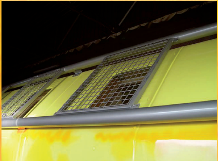
Górna część kontenera LAK II z założonymi i pomalowanymi siatkami okiennymi.
