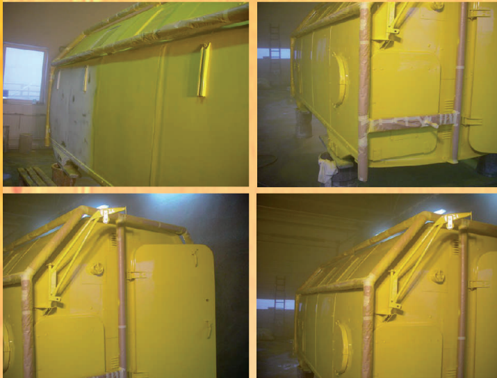
Zamaskowane orurowanie. Kontener podczas malowania pierwszej warstwy.
