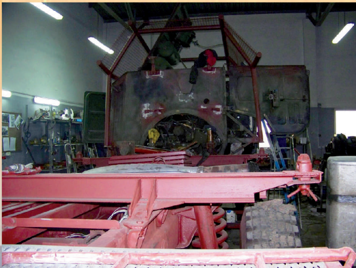
W celu przymocowania kontenera przyspawano dodatkowe elementy ramy.
