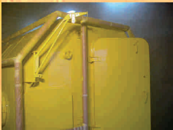
Die maskierte Berohrung. Das Container während der Durchführung der ersten Anstrichschicht.
