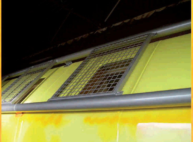
Der obere Containerteil von LAK II mit angebrachten und angestrichenen Fenstergittern.
