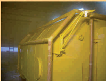
Die maskierte Berohrung. Das Container während der Durchführung der ersten Anstrichschicht.
