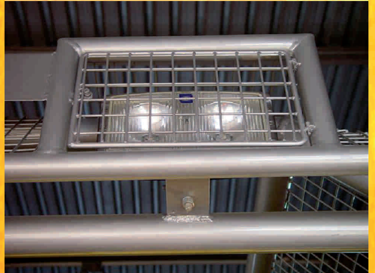
Die am höchsten gelegenen Deckescheinwerfer wurden auch durch Schutzgitter geschützt.
