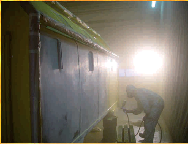
Die erste Anstrichetappe mit der gelben, Zitronenfarbe RAL 116 wurde angefangen.
