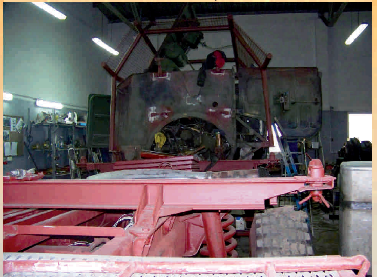
Um das Container zu befestigen, wurden zusätzliche Rahmenelemente angeschweißt.
